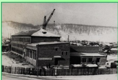
Строительство современного здания школы, 1972г.
